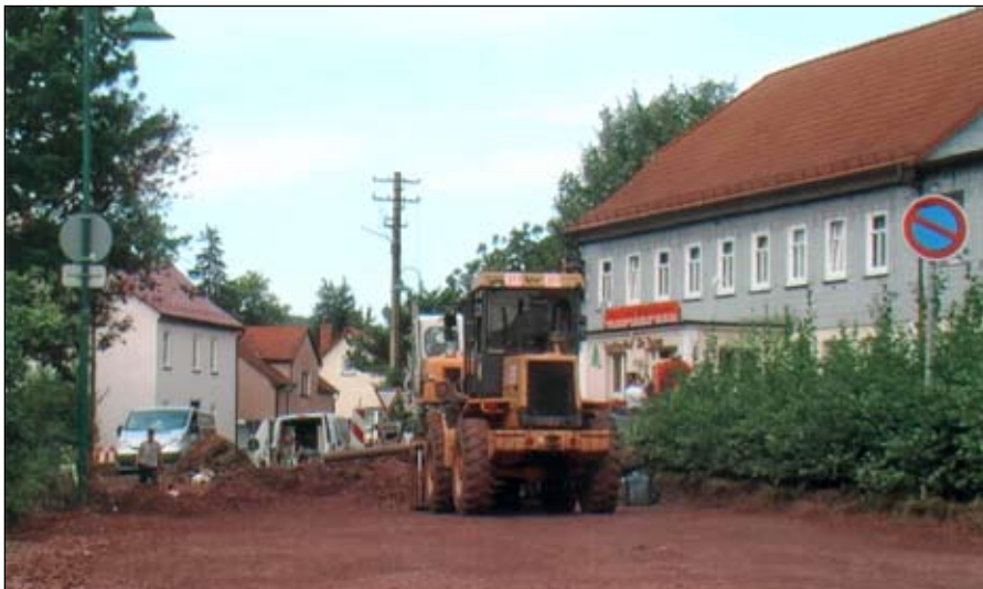
Bauarbeiten in der Cumbacher Straße, September 2012. Foto: H. Prasse
